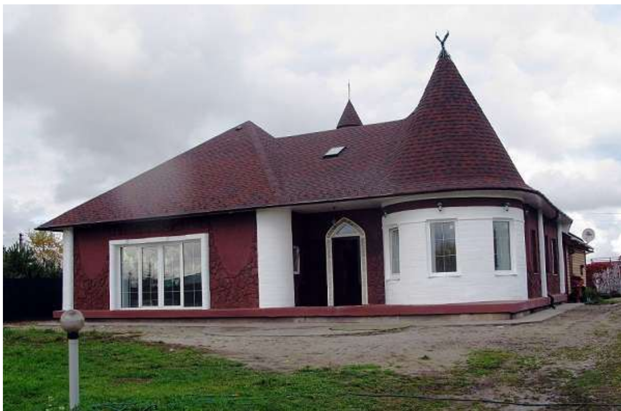
Рис. 12. Напечатанный дом в Ярославле
