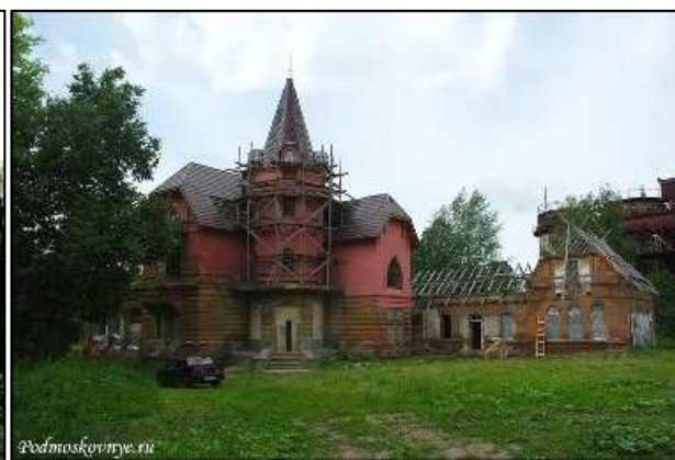
Рис. 2. Реставрационные работы. Фото 2009 г.
