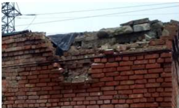
Рис. 1. Разрушение кирпичной кладки
