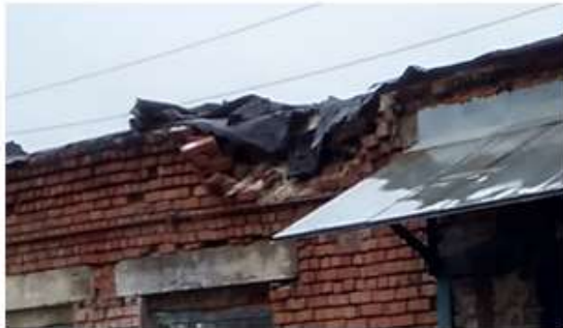
Рис. 1. Разрушение кирпичной кладки
