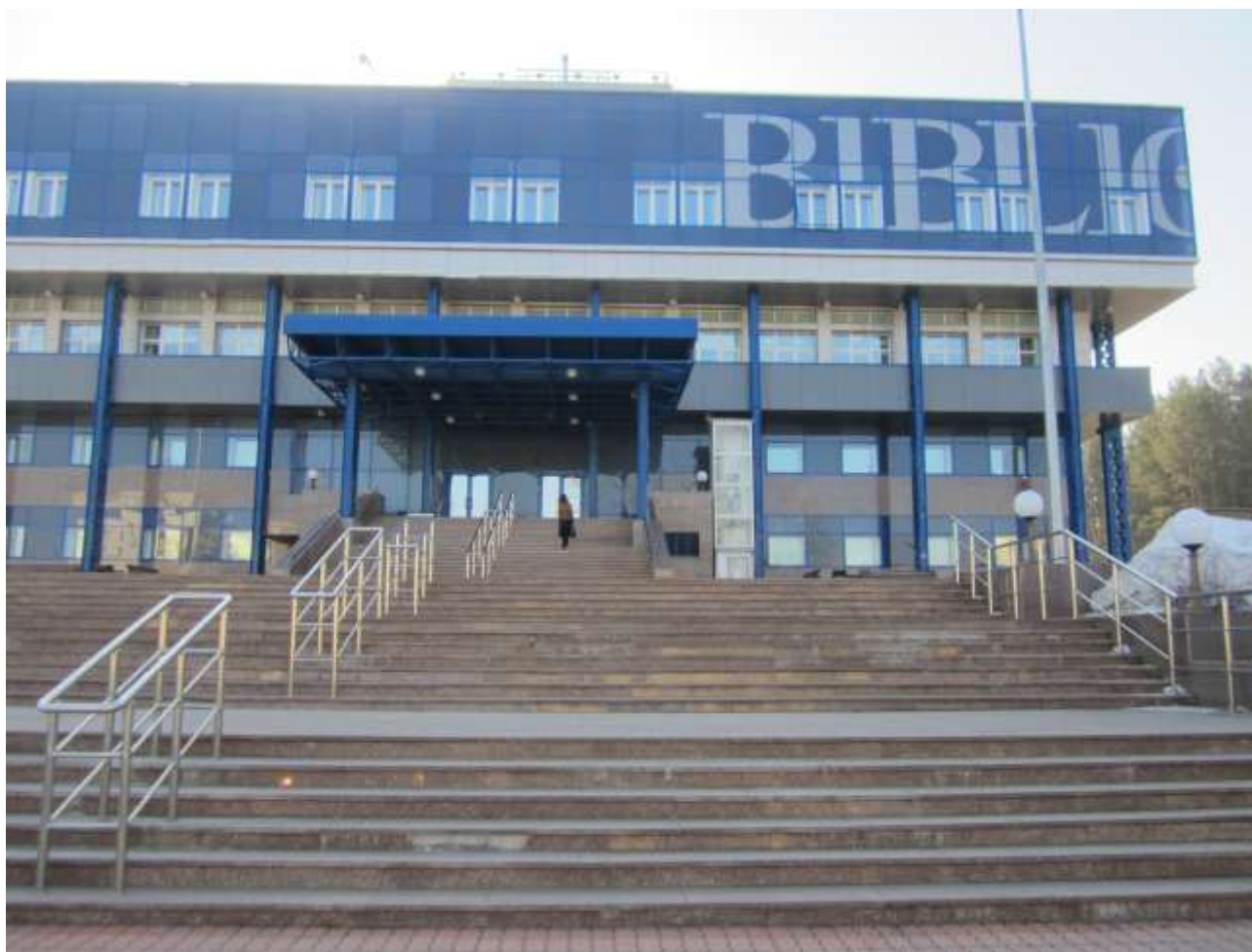
Рис. 1. Гранитная облицовка стен и главная лестница из гранита в здании библиотеки СФУ
