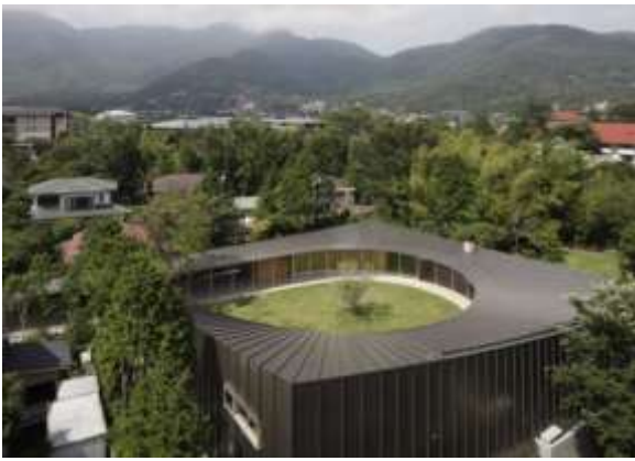
Рис. 13. Здание с каплевидным двориком, префектура Канагава, Япония, архитектор Шигеру Бан
