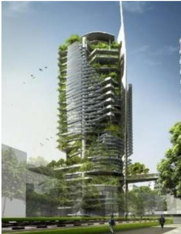
Рис. 12. EDITT Tower, Сингапур, архитектор Кенг Янг
